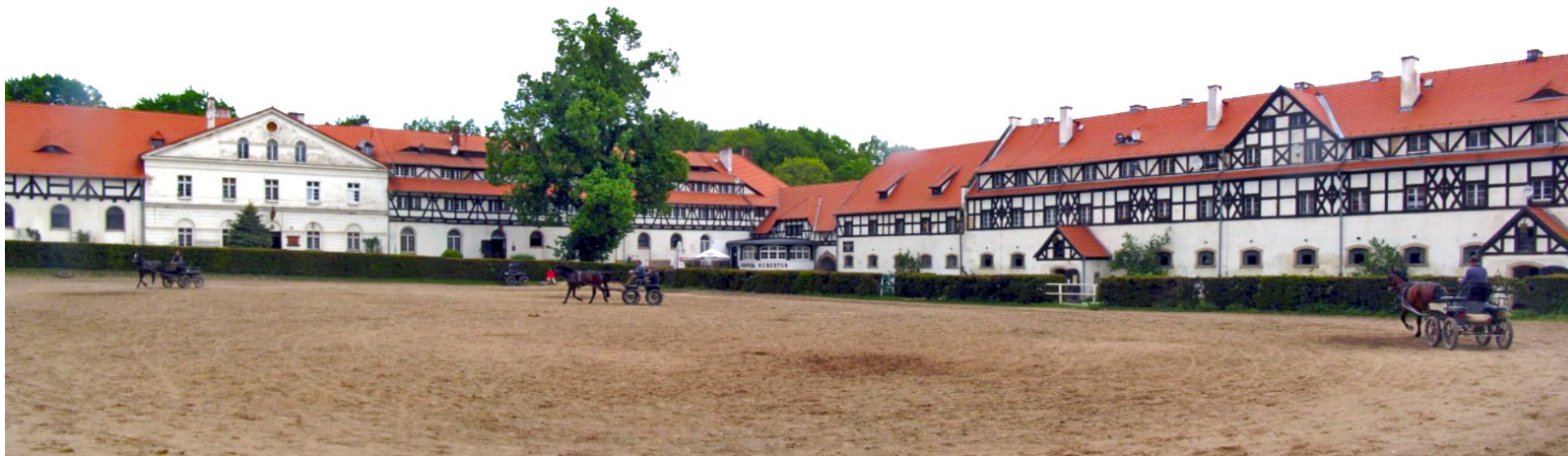
Kompleks zabudowań o zabytkowej konstrukcji szkieletowej – SO Książ. fot. Joanna Przybyłek
