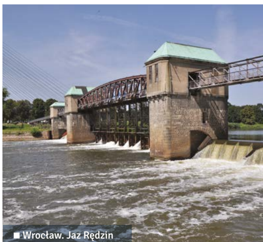
■ Wrocław. Śluza Opatowice
